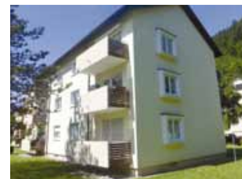
Saniertes Mehrfamilienhaus in der August-Faller-Straße 5, Waldkirch
