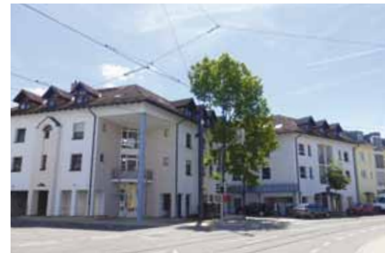
Sanierte Mehrfamilienhäuser in der Zähringer Straße 371 und Bernlappstraße 2
