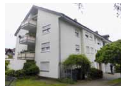
Saniertes Mehrfamilienhaus im Brombeerweg 15
