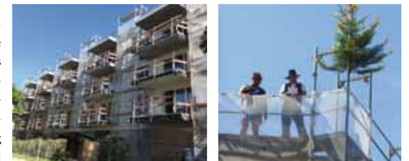
Bauverlauf 2019 Blumenstraße 11, Gundelfingen
