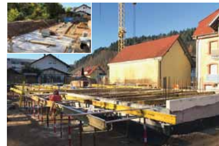
Bauverlauf 2019 Freiburger Straße 3, Elzach
