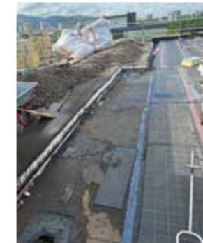
Bischofskreuz 21, Freiburg, Rückbau alter Dichtungs- und Dämmebene
