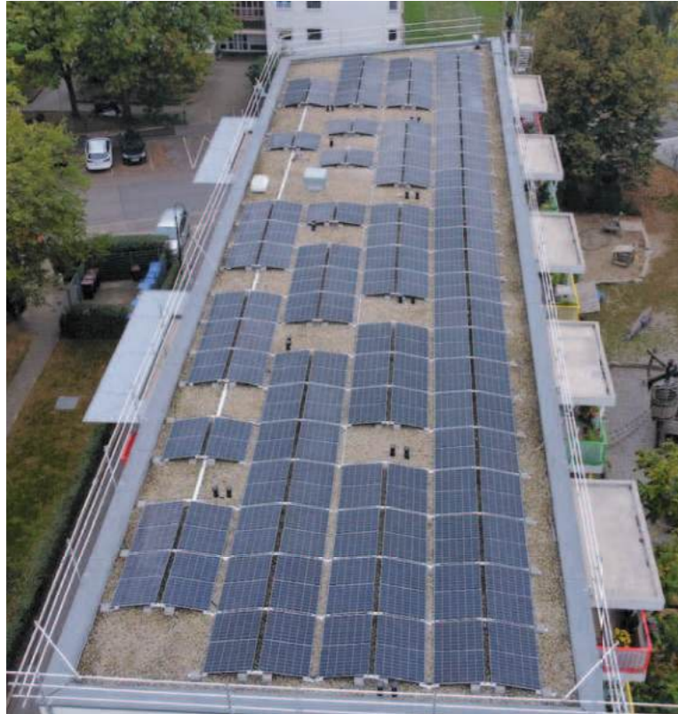
Photovoltaikanlage Flachdach Blumenstr. 11, Gundelfingen
