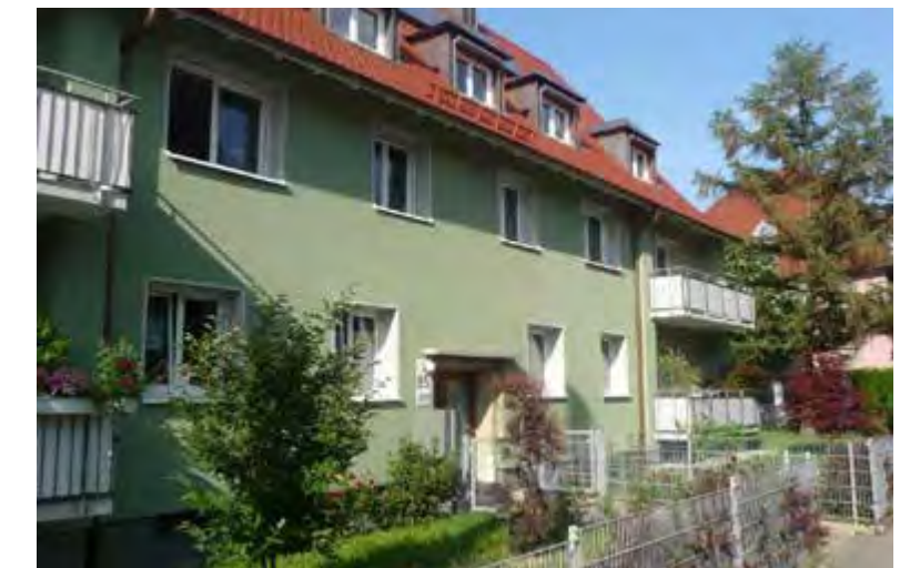
2007 investierte die Heimbau in eine grundlegende energetische Modernisierung des Mehrfamilienhauses Hansjakobstraße 95 (Baujahr 1964) in Freiburg-Littenweiler.
