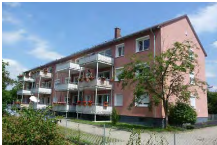
Die 1960 erbauten Wohnhäuser Elsässer Straße 10-12 mit zwölf Wohneinheiten im Freiburger Stadtteil Mooswald wurden 2007 energetisch modernisiert.
