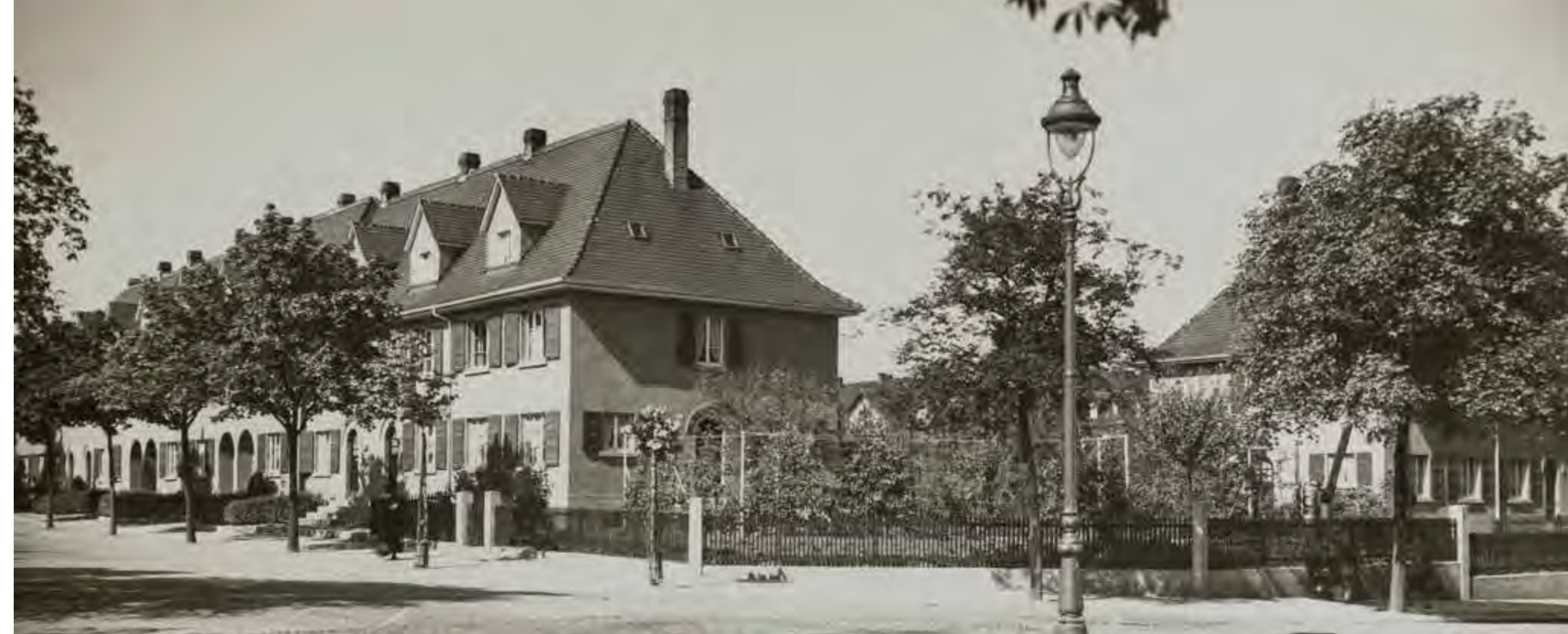
Blick von Norden auf die Wohnhäuser in der Stefan-Meier-Straße 109-127
