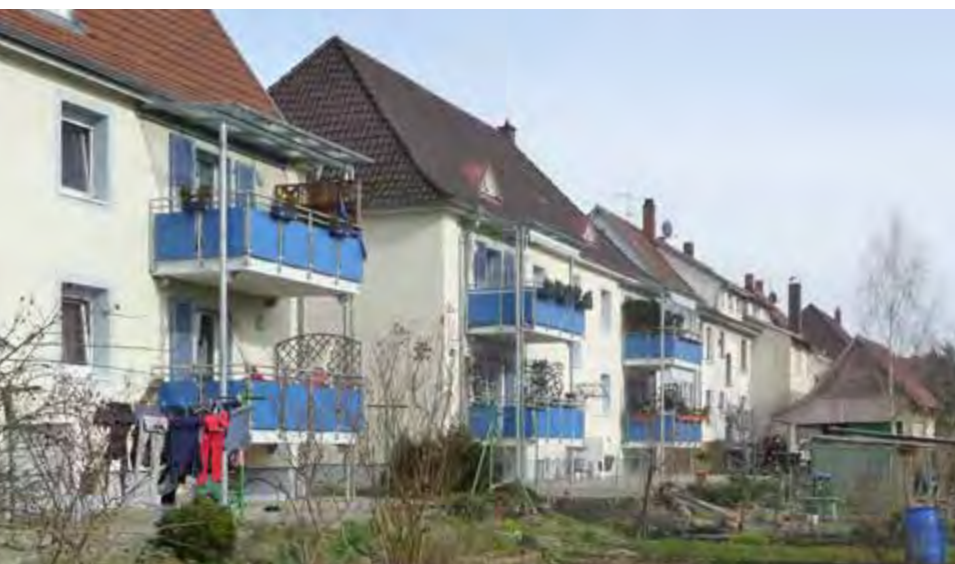
2009 erfolgte die Modernisierung der Wohngebäude Rheinstraße 17/19 in Teningen.
