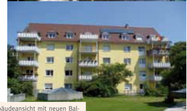
Gebäudeansicht mit neuen Balkonen nach der Modernisierung
