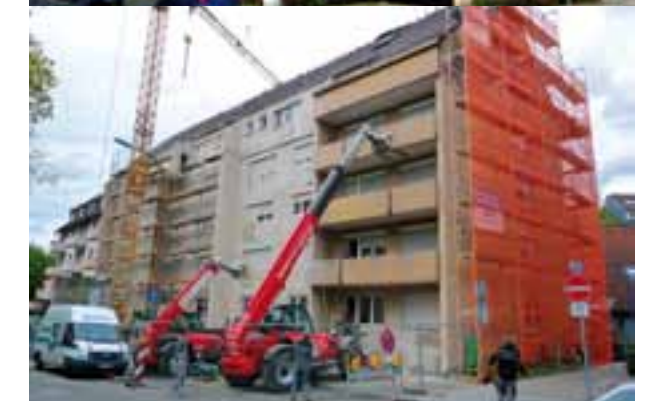
Hugstetter Straße 15/17, Freiburg. Modernisierung des in die Jahre gekommenen Gebäudes ...
