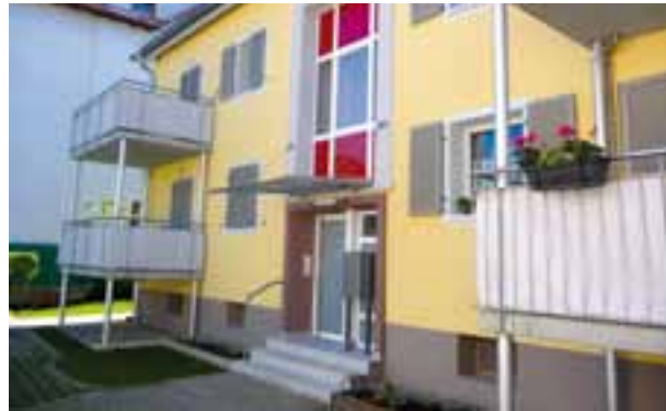
Eingangsbereich der Scheffelstr. 13 nach der Umbauphase ...
