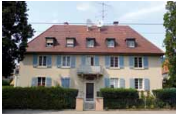
Das Sechsfamilienhaus Hansjakobstraße 13 in Freiburg vor ...
