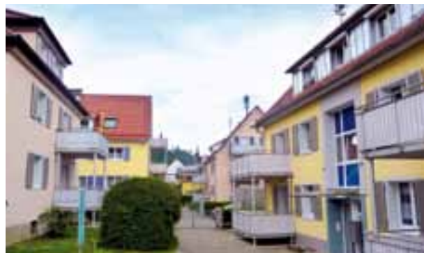
und Hebelstraße 27 in Waldkirch nach der Modernisierung
