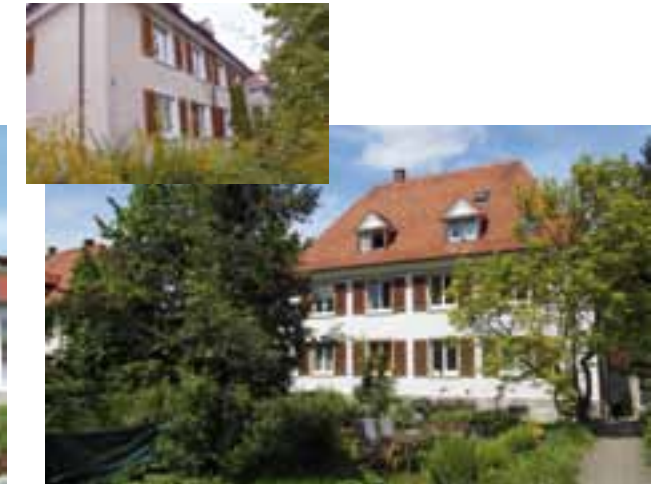
Hansjakobstraße 51/53, vor und nach der Sanierung
