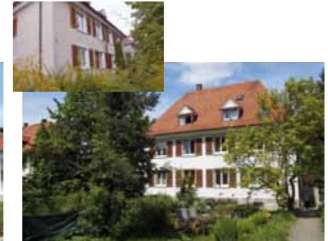
Hansjakobstraße 51/53, vor und nach der Sanierung
