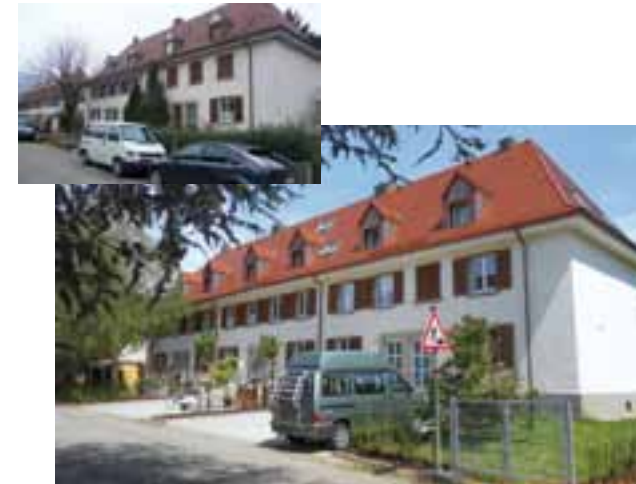
Dimmlerstraße 11-29, vor und nach der Sanierung
