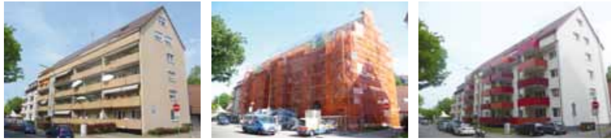
Bilder: Hugstetter Straße 15/17 vor, während und nach dem Umbau
