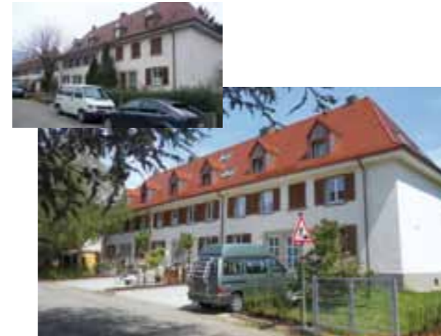
Dimmlerstraße 11-29, vor und nach der Sanierung
