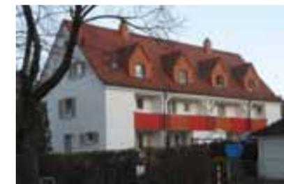
Die Balkone wurden neu abgedichtet und erhielten einen neuen Holzbohlenbelag. Die Geländerfront der Balkone wurde mit witterungsbeständigen Zementfaserplatten in wechselnden Rottönen verkleidet.
